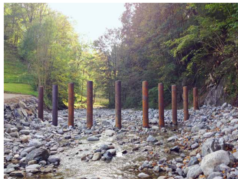
10 mit Beton verfüllte Stahlrohre sollen im Brüelbach im Falle eines Hochwassers Schwemmholz zurückhalten.
