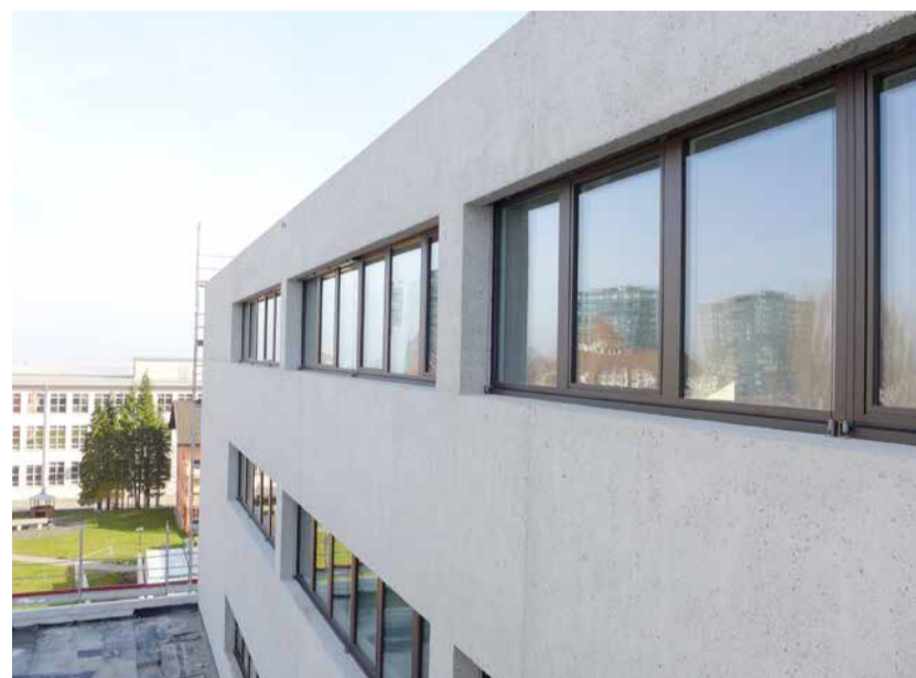
Für die helle Fassadenwirkung wurde beim Neubau Regatron dem Beton Weisszement beigemischt. Das Projekt stammt aus der Feder der Andy Senn Architekt BSA SIA GmbH.
