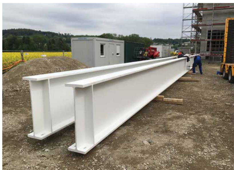
Im Einsatz: HEM 1000 S355 – der grösste Stahlträger, den es als Standardprofil gibt
